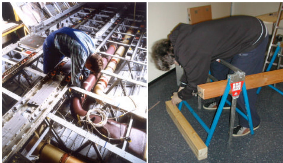
Ausstattungs montage im Flugzeug, Frachtraum, Mitarbeiter steht auf „Stringern“ zwischen den Schienen des Frachtladesystems
